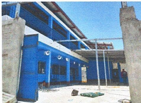
Foto 2: CANALES Y BAJADAS DE AGUA PLUVIAL
