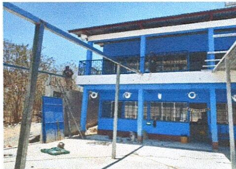
Foto1: CUBIERTA DE LÁMINA
